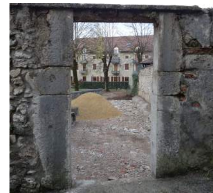
Réouvertures de percements dans le mur d'enceinte du parc St Joseph.
