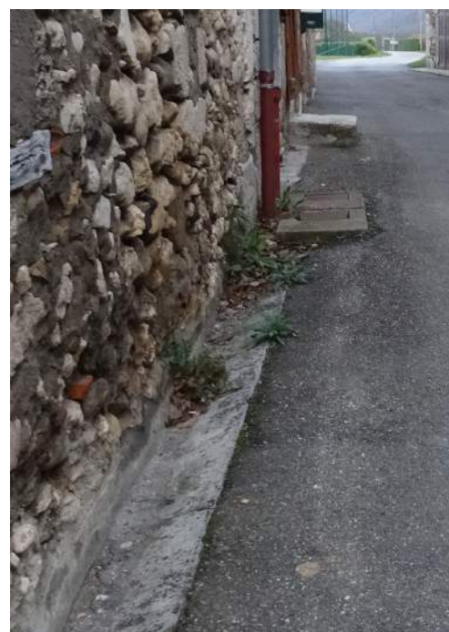
Rejet des eaux en pied de façade qui fragilise les murs.
