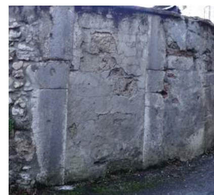
Réouvertures de percements dans le mur d'enceinte du parc St Joseph.
