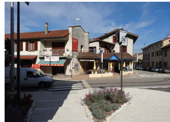
Bar-restaurant / épicerie à intégrer à la réflexion pour une mise en valeur des abords
