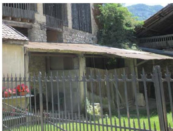
*Granges accolées à des séchoirs et des habitations : trois travées dont celle au centre est fermée par une porte charretière en bois. Les murs maçonnés s'arrêtent avant la charpente, qui repose alors sur les murs mitoyens et des piliers.*
