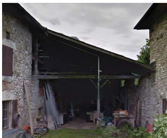
*Granges implantées entre deux constructions en maçonnerie, la charpente reposant sur les murs latéraux, l'une sans point d'appui intermédiaire, l'autre avec un poteau bois et jambes de force sur fondation maçonnée.*
