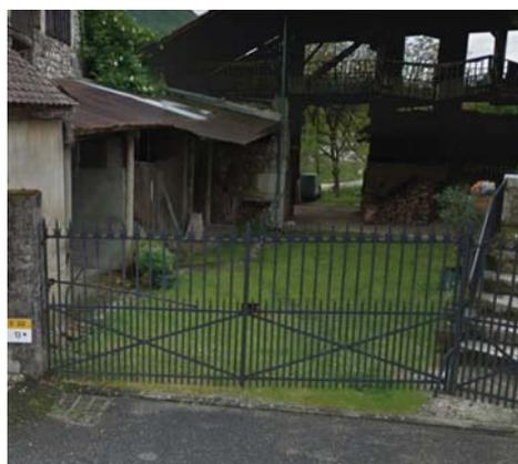
*Exemple d'un portail en fer plat, à barreaudage droit à pointes et anneaux, rythme doublé avec contreventement croisé en soubassement.*
