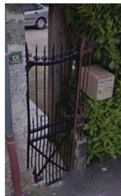
*Exemple d'un portail en tube carré, à barreaudage droit à pointes et volutes, rythme doublé avec contreventement croisé en soubassement, traverse intermédiaire simple.*
