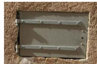
*Exemple de coffrets dissimulés derrière un volet en métal brut ou peint avec ou sans pentures, battant vertical ou horizontal.*
