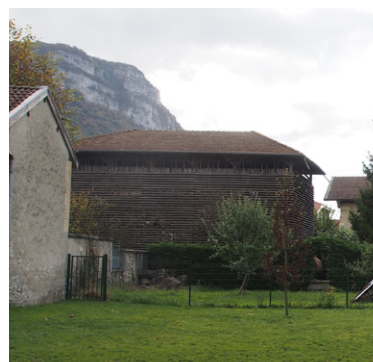
Un séchoir indépendant au village. Les arrangements des claustras sont remarquables et participent à l'ambiance des espaces publics du village.
