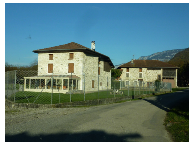
Anciennes fermes reconverties en logements
