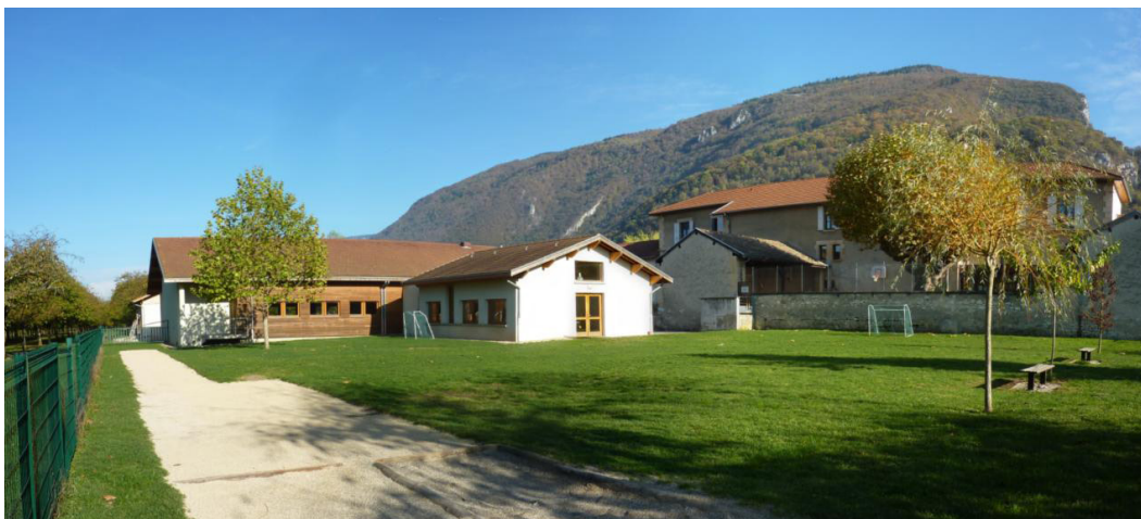
La salle des fêtes avec en premier plan le restaurant scolaire depuis l'arrière du bâtiment-école / mairie
