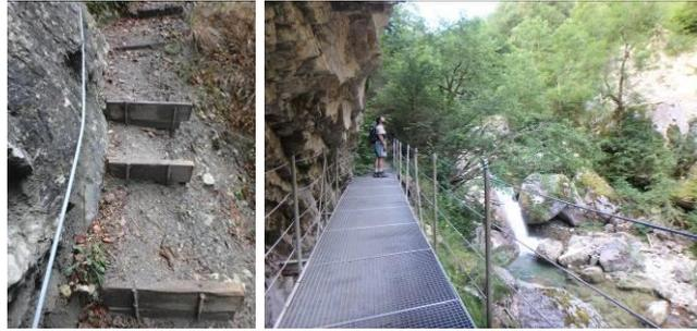
**Photo 40 : Aménagement pour le franchissement piéton de passages difficiles : passerelles métalliques suspendues, marches d'escaliers et câble de main courante.**
