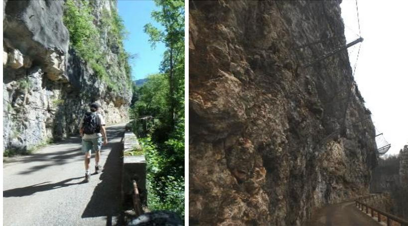
**Photo 38 : Habitats des parois calcaire exposées à l'amont des gorges : à gauche, avant travaux en juillet 2016, à droite après travaux de dévégétalisation et installation de filets en novembre 2016.**
